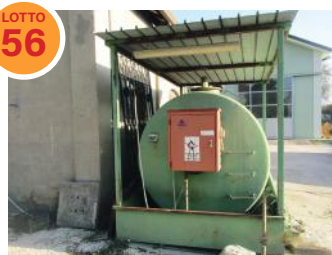
CISTERNA PER GASOLIO + SPAZZOLATRICE
